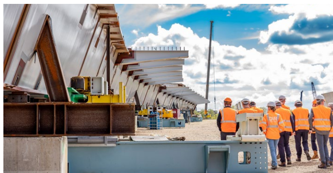
Visite du chantier de raccordement de la SUD 3 à Rouen
