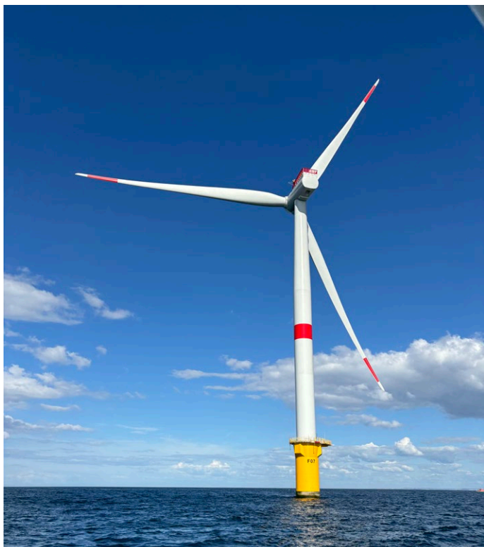
Parc éolien en mer de Fécamp
